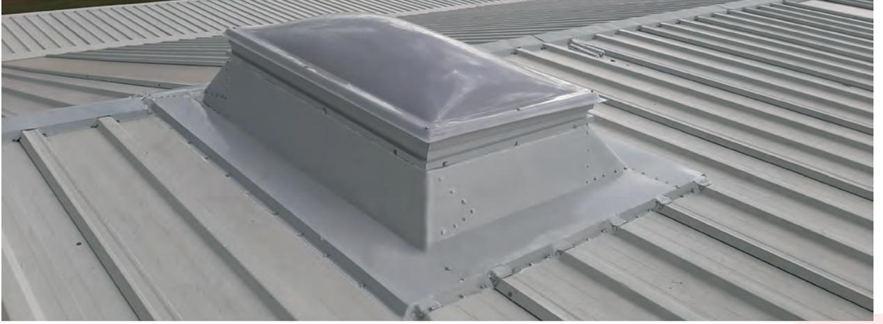
Otomatik ve şebekeden bağımsız olarak elle devreye sokulabilen duman tahliye ve havalandırma mekanizmaları, yangın durumunda, mahaldeki dumanın tahliyesi ve ısı yükünün alınması anlamına gelen hızlı ve etkin sistemlerdir.
